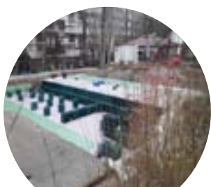
Les travaux avancent, les nouveaux courts sont prévus début juin
